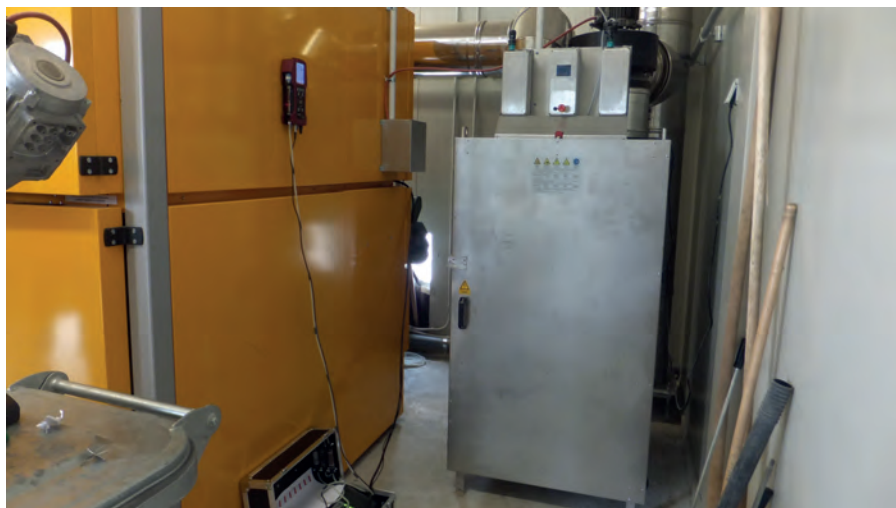
Figura 2 – Filtro elettrostatico esterno (OeKorona della Oekosolve) applicato ad una caldaia a cippato di 300 kW.
